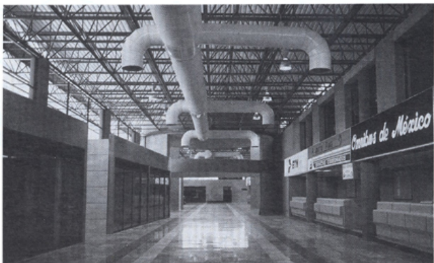
Vista exterior de los andenes y las salas de espera Vista interior del vestíbulo Vista interior de los comercios y de las taquillas
