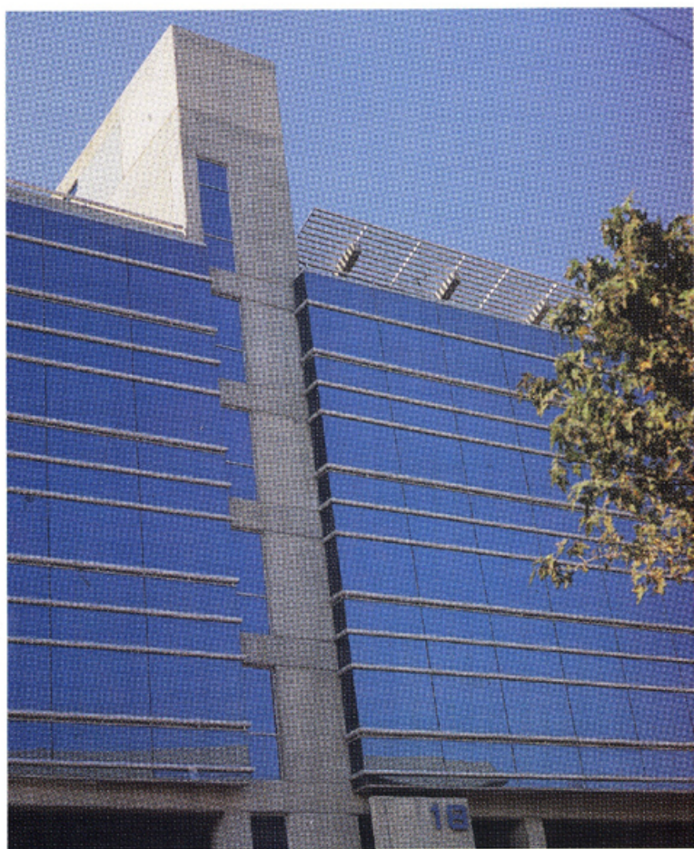
Vista exterior del pergolado del Pent Office
