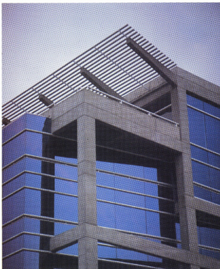
Vista exterior desde la Av. Sor Juana Inés de la Cruz
