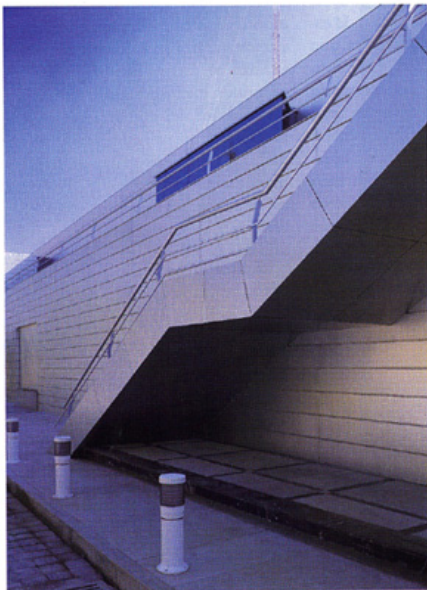
Escaleras de emergencia
