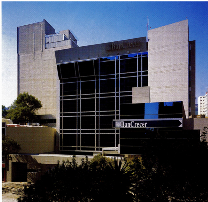
Corporativo en contexto de prismas grises de concreto
