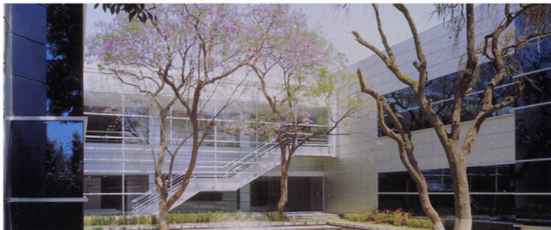
Vista del patio interior
