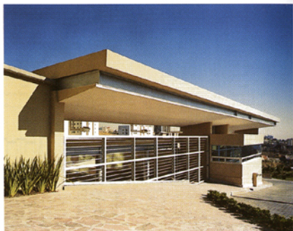
Vista del acceso
